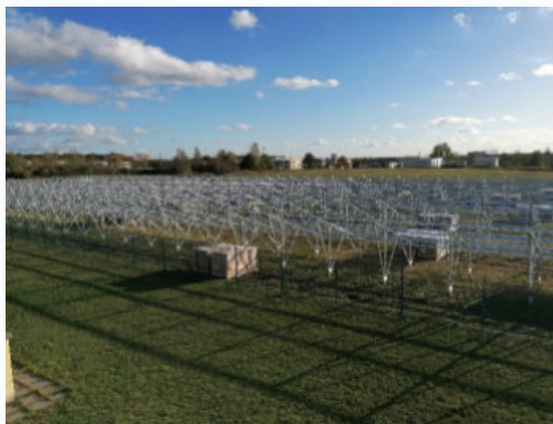
Abbildung 8: Unser Solarpark wird aufgebaut. Netzgang ist in 2024 geplant.
